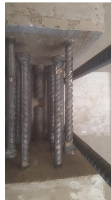
Teste com armaduras dos pilares-parede e viga
