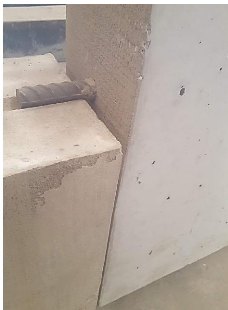
Teste com apoio provisório
